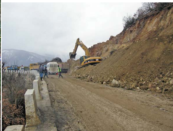
Fig. III.9 Punime në Rrugën e Arbrit
