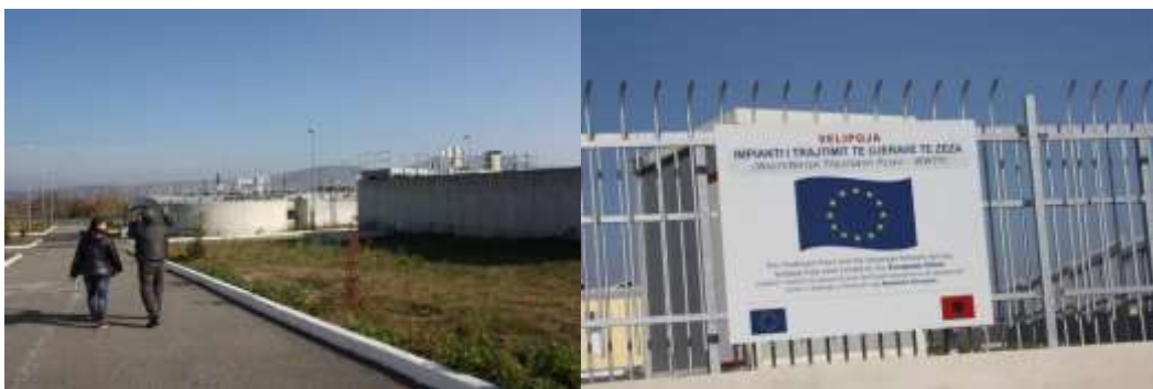
Figura 1.15. Sistemi i kanalizimit dhe impjanti i përpunimit të ujërave të zeza në Velipojë. (O. Luka)
