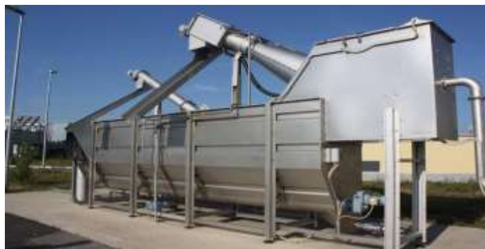
Figura 1.16. Kolektori ku bëhet filtrimi i mbetjeve të ujërave të zeza (O. Luka)
